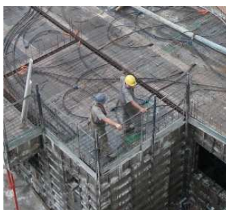
Figura 3.4: Funcionários aguardando chegada do concreto
